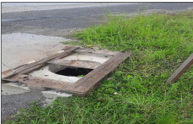
Ilustración 30 Huecos expuestos en el paso peatonal, sector de La Lima.
