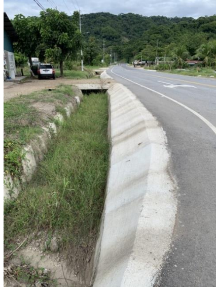
Ilustración 75: Proyecto “Mejoramiento y Rehabilitación Ruta N° 160 'Playa Naranjo Paquera’”. Tomada el 08 al 10 de noviembre 2021.
