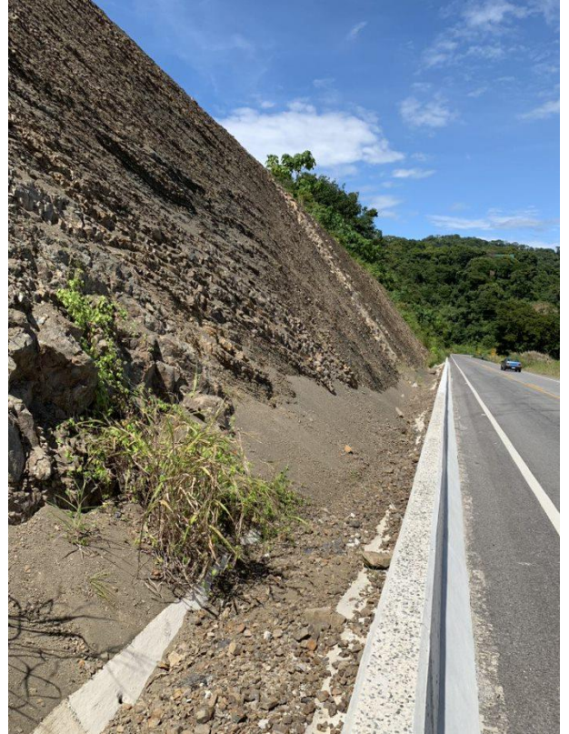
Ilustración 74: Proyecto “Mejoramiento y Rehabilitación Ruta N° 160 'Playa Naranjo Paquera”. Tomada el 08 al 10 de noviembre 2021.
