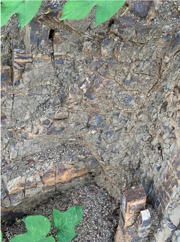
Ilustración 35: Material típico de taludes, sin obras de estabilización.
