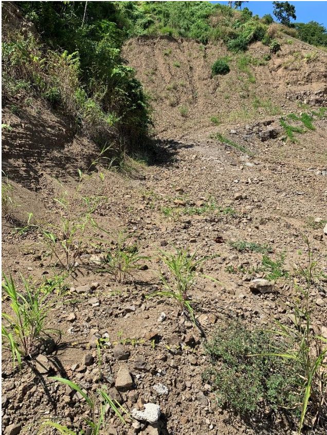
Ilustración 40: Muestra de desprendimiento de masa de materiales de talud.
