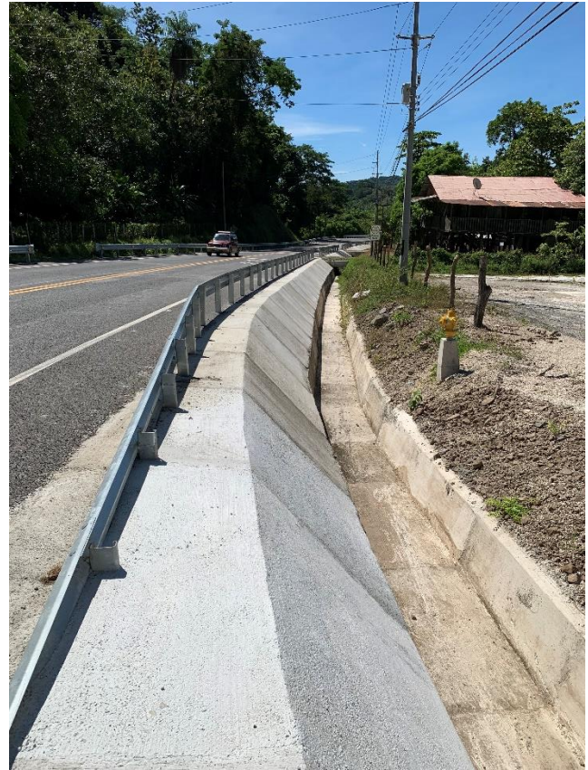
Ilustración 60: Cunetas de gran tamaño, con barandas flexibles, con hidrante detrás del canal.
