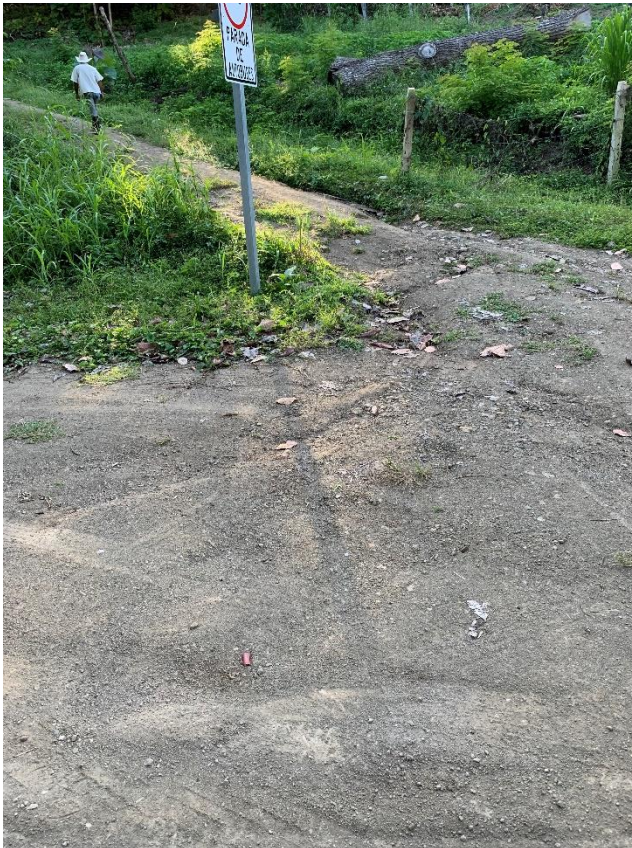
Ilustración 50: Sedimento en acceso a propiedad, que cubre acera.
