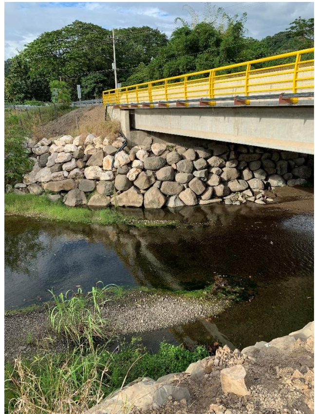
Ilustración 26: Escolleras en puentes
