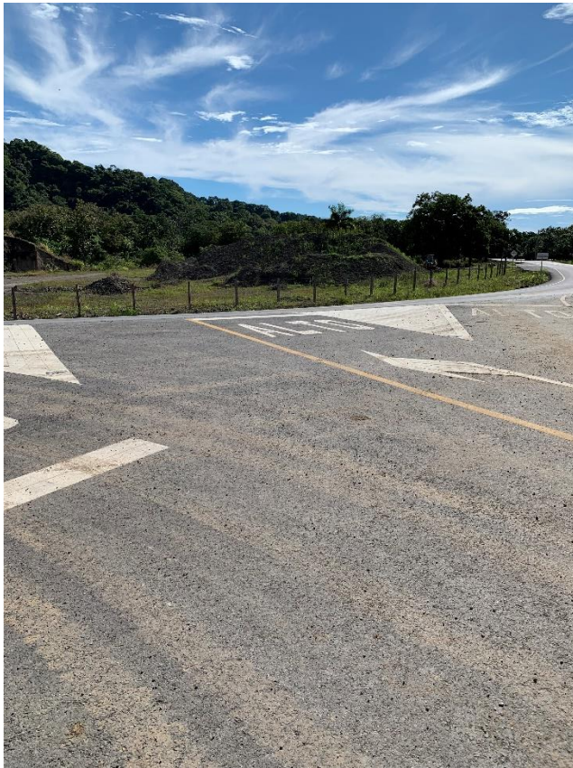
Ilustración 57: Intersección con diseño geométrico adecuado en transición.
