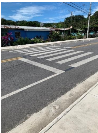
Ilustración 4: Señalización vertical inexistente
