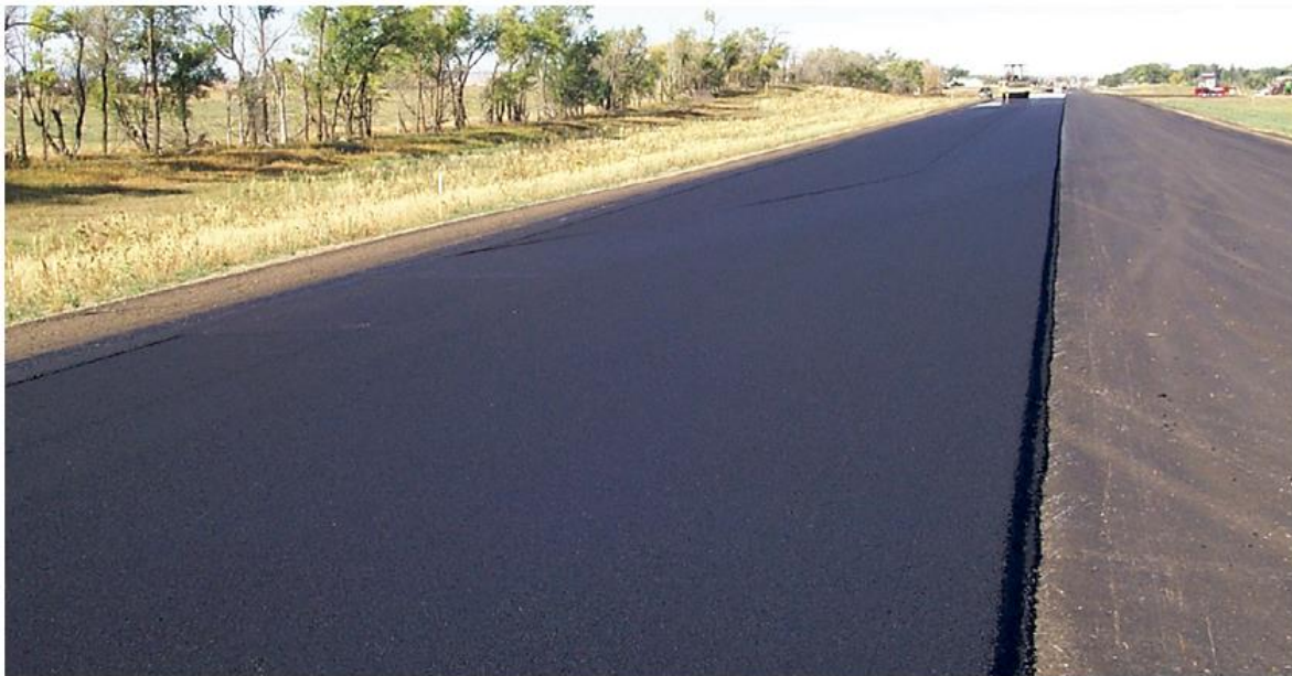
Ilustración 3: imagen ilustrativa de correcto acabado de mezcla asfáltica
