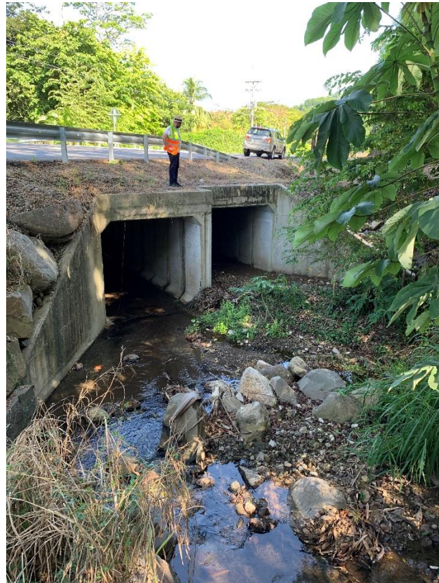
Ilustración 18: Alcantarillas mayores.
