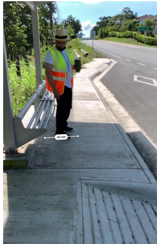
Ilustración 9: Diseño de parabuses con problemas de distribución, no cumple Ley 7600
