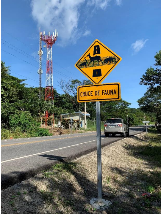
Ilustración 6: Señal vertical con altura y retiro inadecuado.
