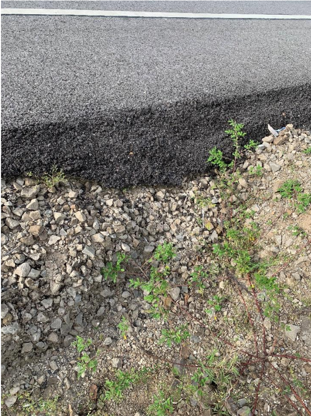
Ilustración 14: Exposición de base y subbase granular.
