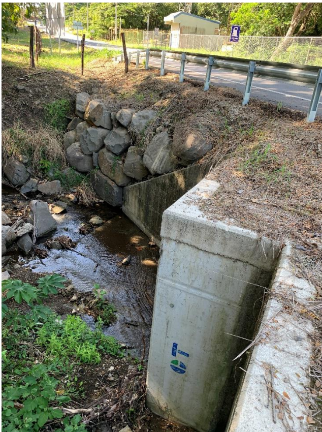
Ilustración 17: Alcantarillas mayores.
