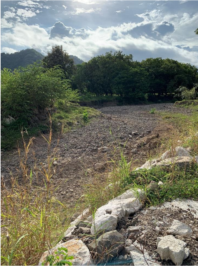
Ilustración 28: Geomorfología del cauce próxima al puente.
