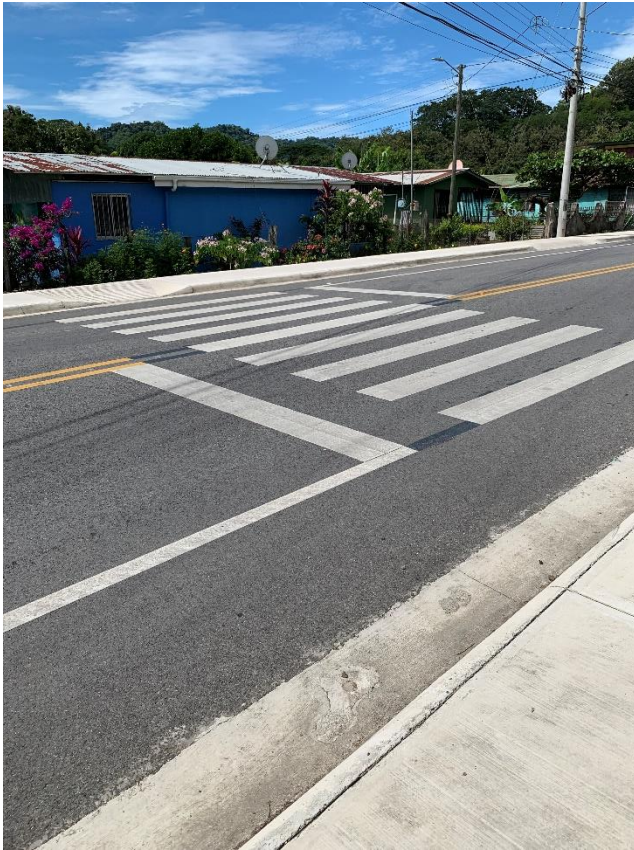
Ilustración 59: Paso peatonal con señalamiento horizontal pero no vertical.
