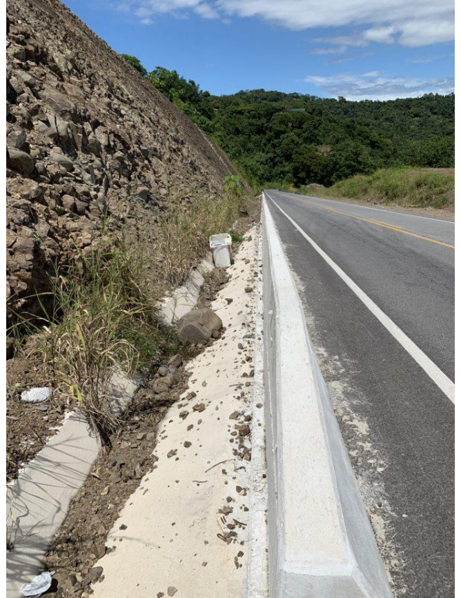
Ilustración 73 Proyecto "Mejoramiento y Rehabilitación Ruta N° 160 'Playa Naranjo Paquera". Tomada el 08 al 10 de noviembre 2021.
