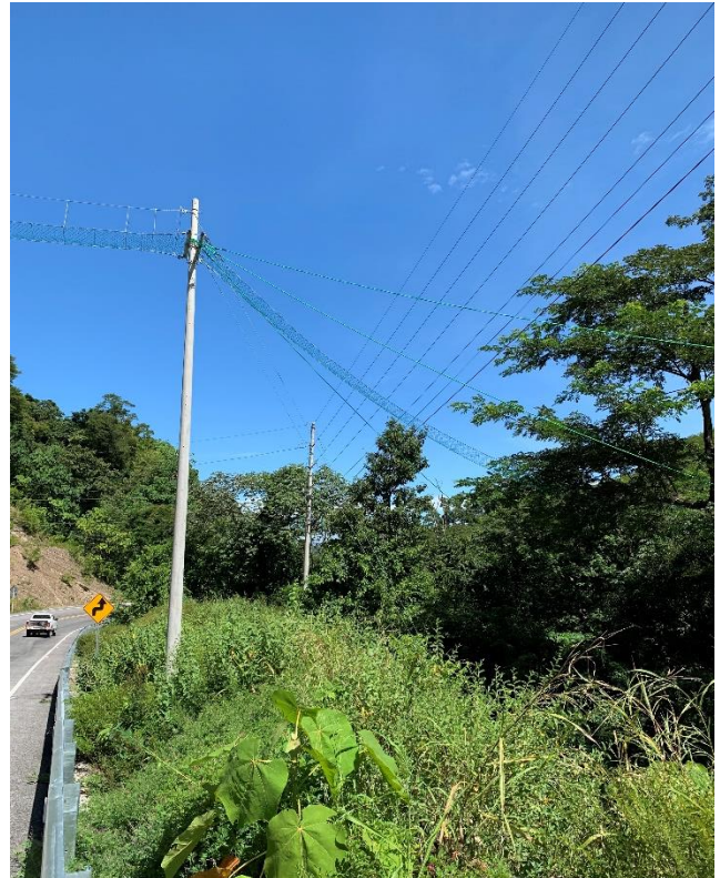
Ilustración 11: Paso de fauna superior.
