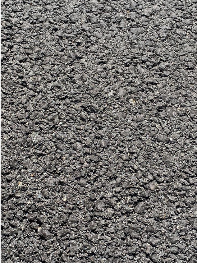
Ilustración 13: Mezcla abierta y mal sellada.
