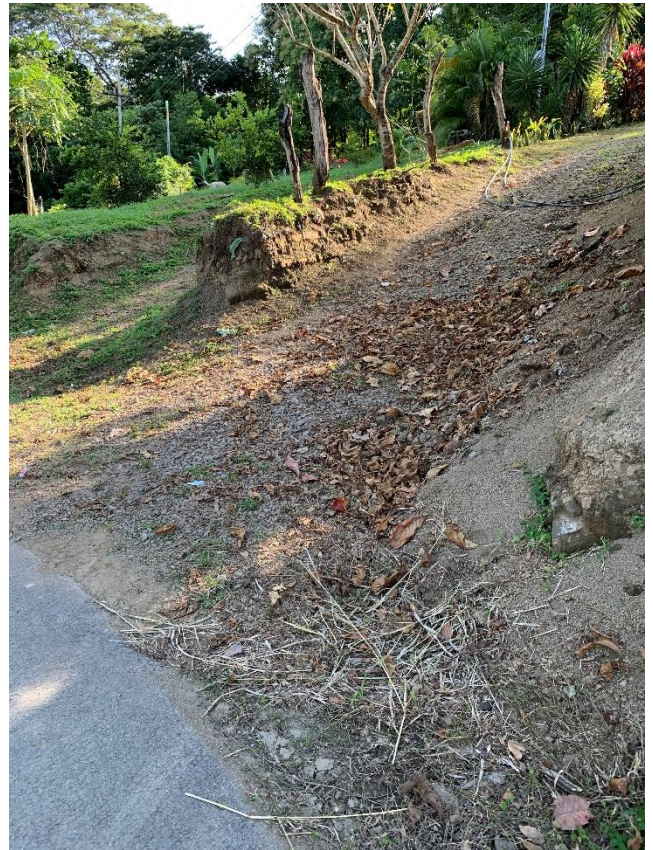
Ilustración 44: Accesos a viviendas mal desarrollados.
