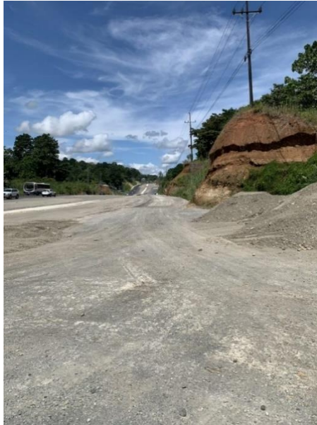
Ilustración 5 Mantenimiento a taludes.
