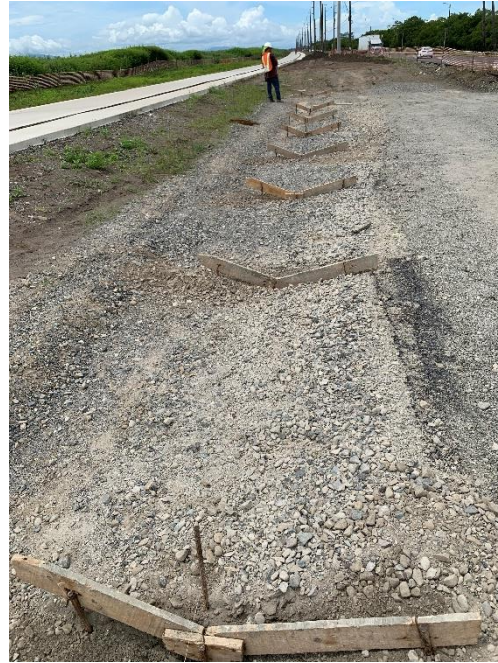
Fotografía 18: Drenaje, cuneta V.
