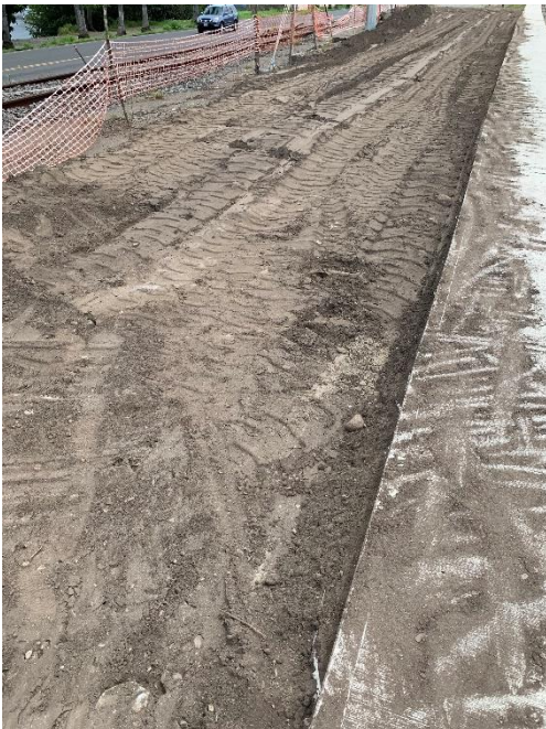
Fotografía 11: Cerramiento en excavación
