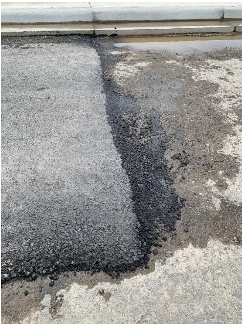
Fotografía 27: Paño de prueba asfáltico.
