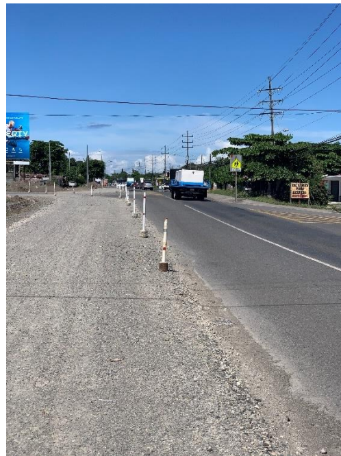
Fotografía 35: Ampliación en retorno.
