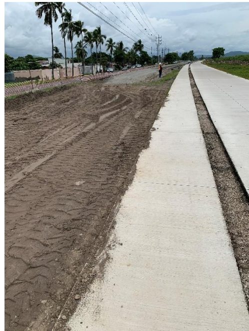
Fotografía 12: Movimiento de tierras en subrasante
