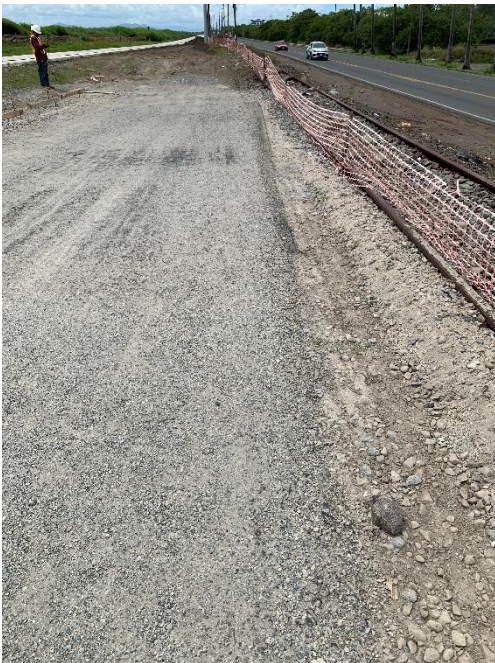
Fotografía 15: Sello de arena en base estabilizada.
