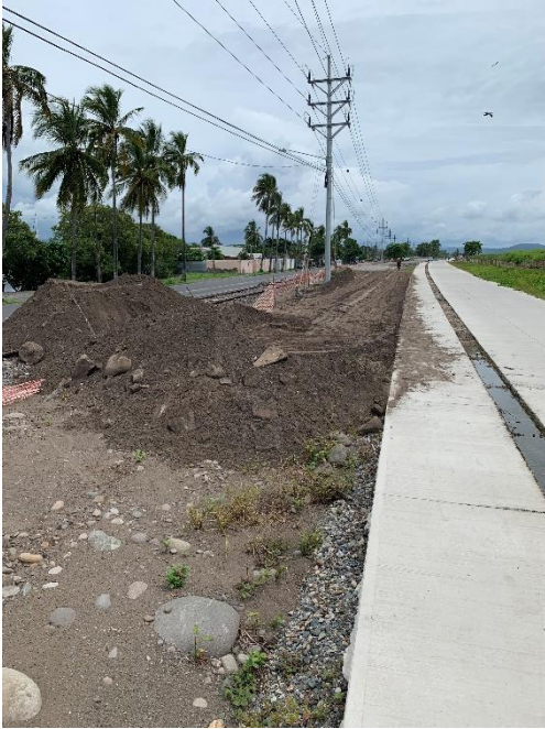
Fotografía 9: Excavación para pavimento
