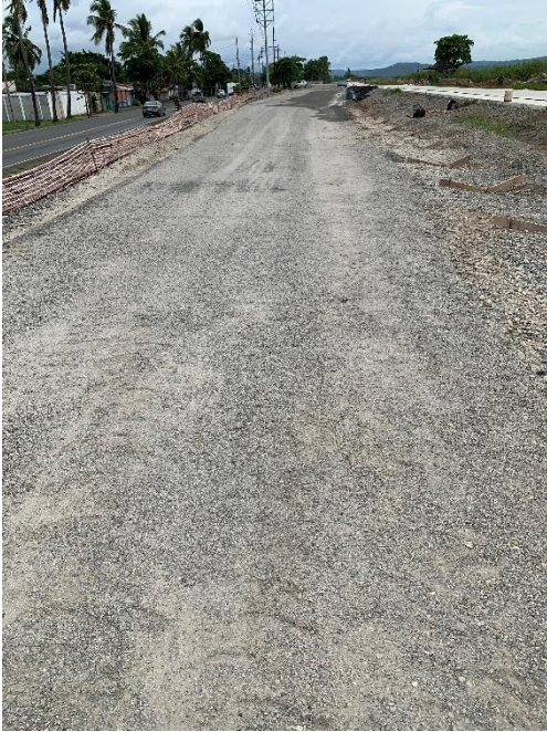
Fotografía 13: Base con imprimación.
