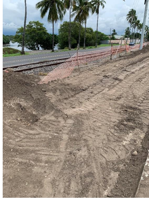
Fotografía 10: Excavación para pavimento
