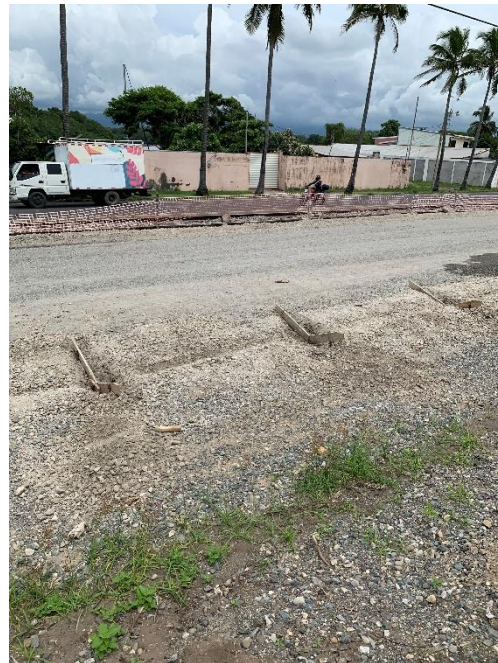
Fotografía 16: Sello de arena en base estabilizada.
