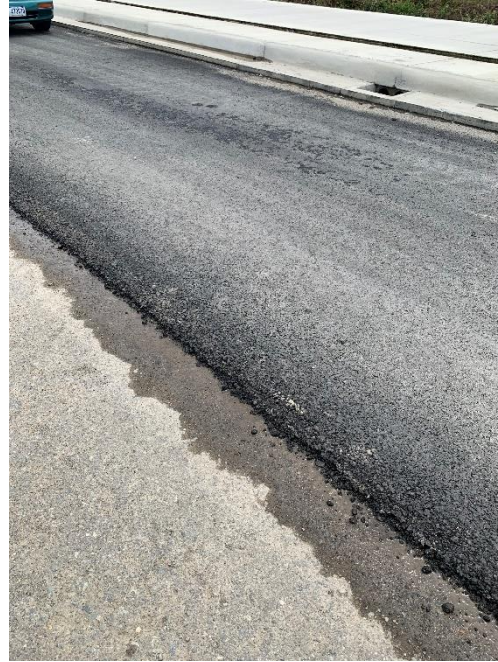
Fotografía 26: Paño de prueba asfáltico.
