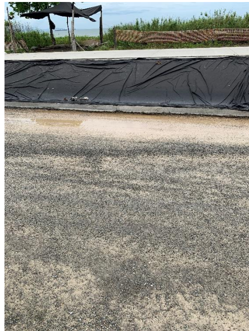
Fotografía 20: Cuneta con protección de talud.
