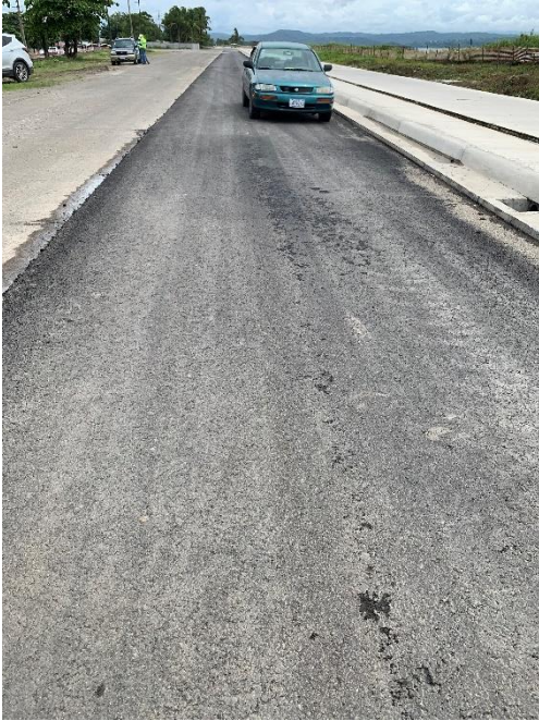
Fotografía 25: Paño de prueba asfáltico.
