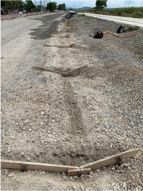
Fotografía 17: Drenaje, cuneta en V.
