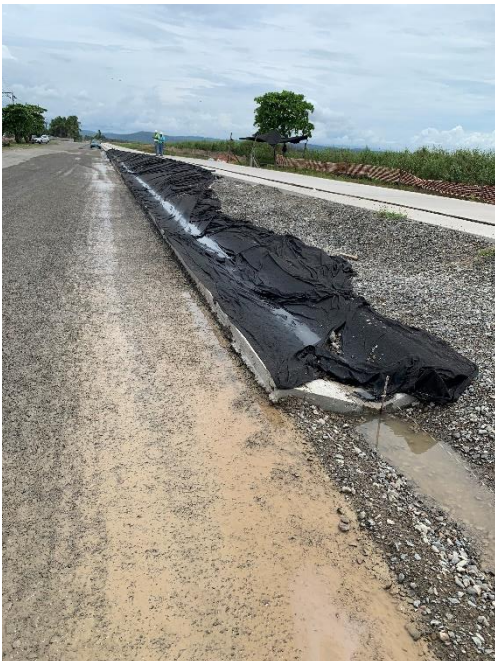
Fotografía 19: Cuneta V colada.
