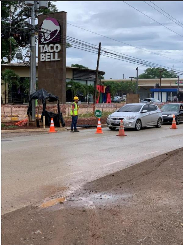
Ilustración 54 Intercambio Limonal, rampa de aproximación, costado este de la vía, con losa de pavimento lista y control vehicular
