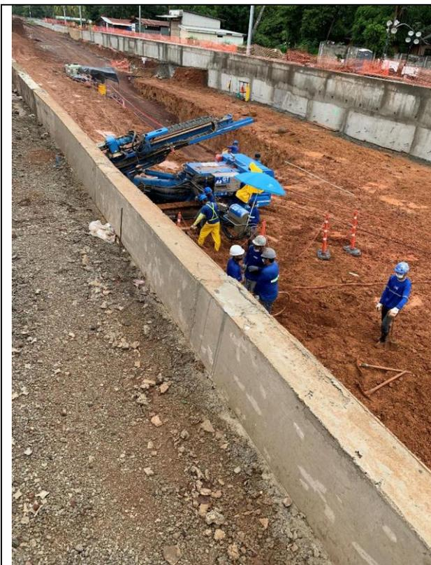
Ilustración 56: Intercambio Limonal, Construcción de muro tipo soil nailing
