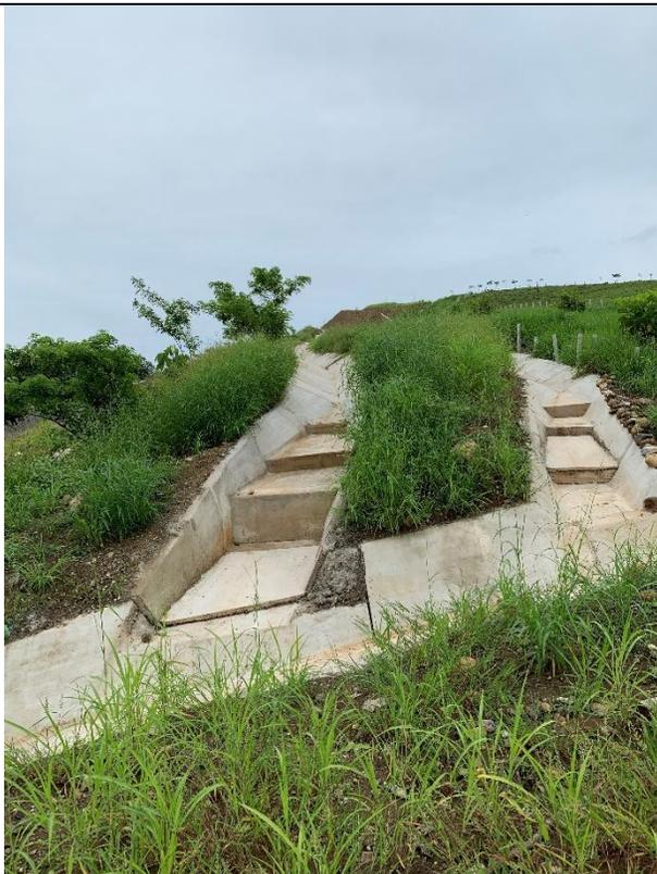
Ilustración 63: Obras de drenaje para cotrol de erosión en taludes.
