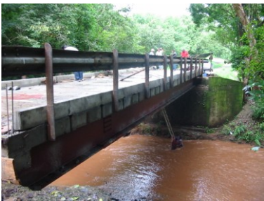
Puente sobre el río Buena Vista de Sámará
