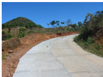
Reparación de caminos vecinales de San Mateo, Alajuela
