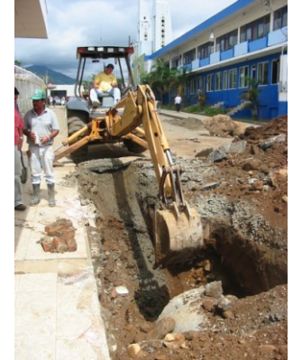
Alcantarillado pluvial San Isidro, Pérez Zeledón
