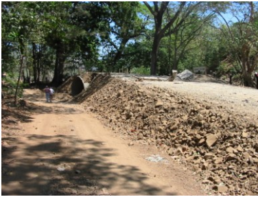
Alcantarilla en Quebrada La Taranta, Buena Vista de Sámará
