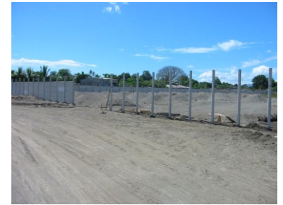
Relleno y cerramiento Terminal Multiservicios Pesqueros, El Carmen, Puntarenas
