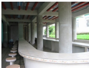
Construcción del Centro de Atención Infanto Adolescente, Florencia, San Carlos
