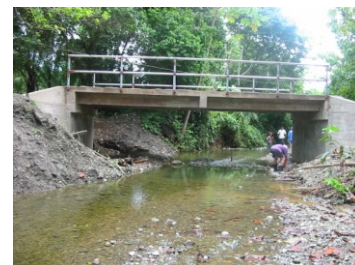
Puente río Caracol, Laurel, Corredores
