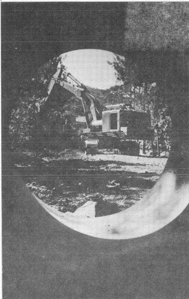
A través de uno de los tubos de grueso calibre, de la línea de conducción del proyecto de Puente de Mulas, puede apreciarse el retroexcavador empleado en su colocación y en la perforación de zanjas.
