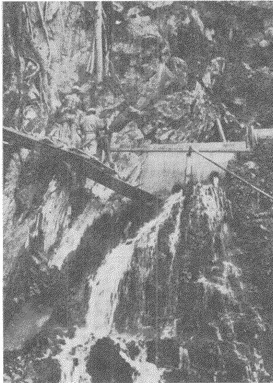
Fuente N° 4 de Puente de Mulas, ya captada. Produce 44 litros por segundo de agua de excelente calidad la que se conduce por tubería de acero.
