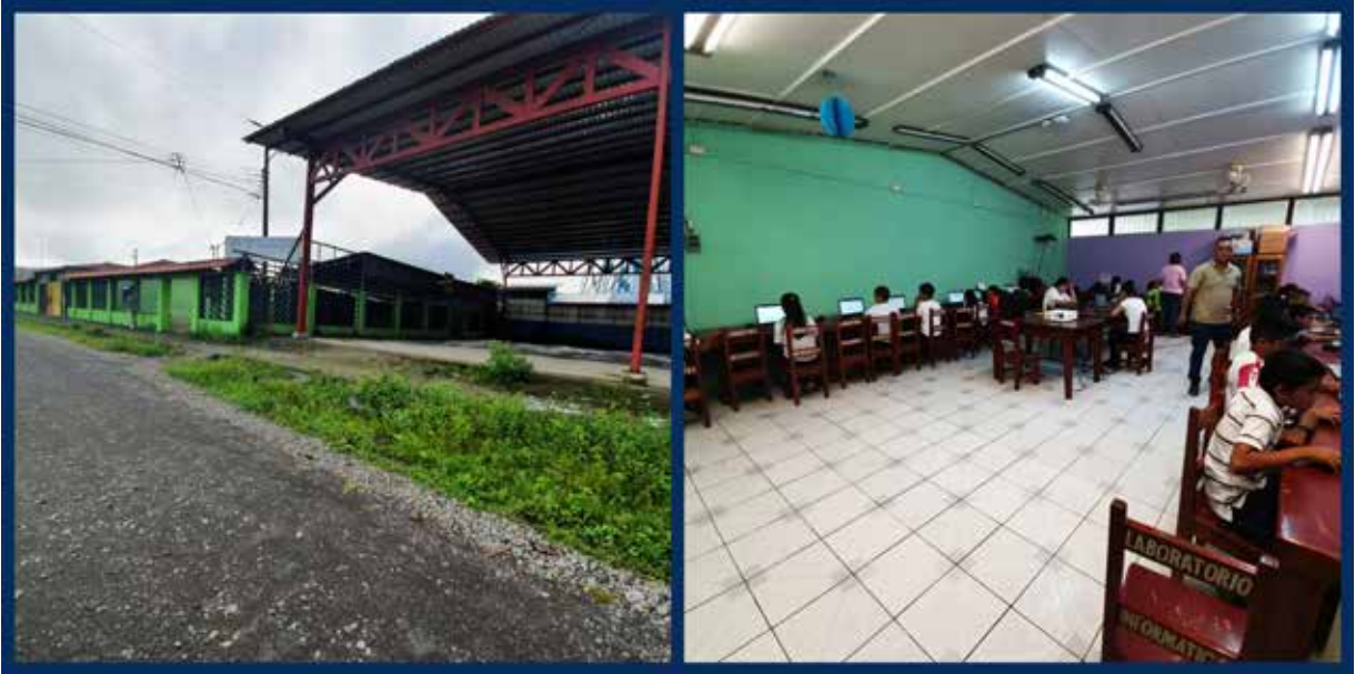
Escuela El Progreso
